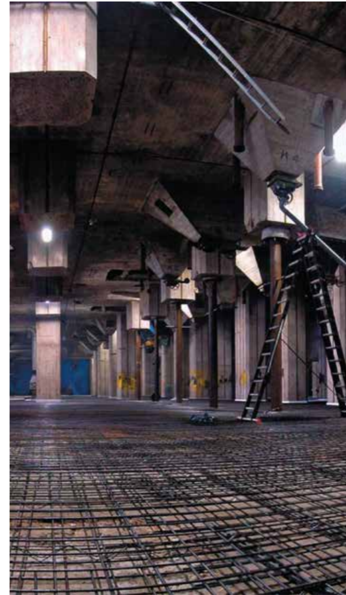
reinforcement ready to pore concrete for the fortified floor phase 2 Source: J.Keijneans (2004) Springend van bestaand naar nieuw, Cement
