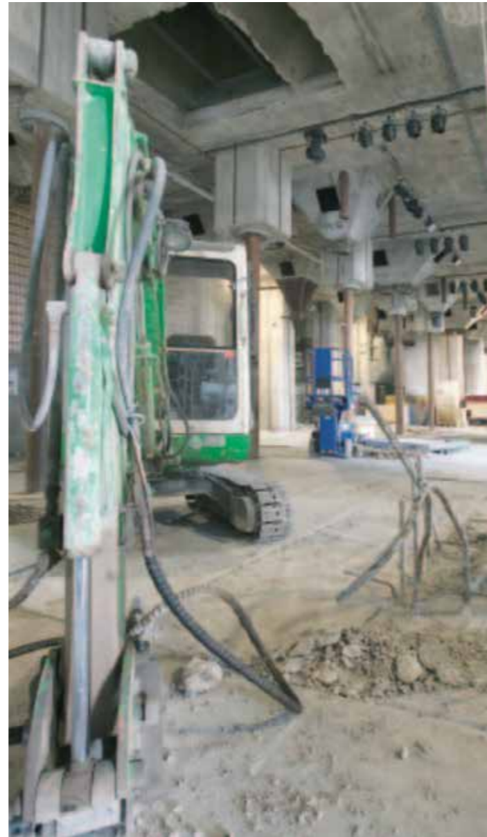
construction work on columns phase 2 Source: J.Keijneans (2004) Springend van bestaand naar nieuw, Cement
