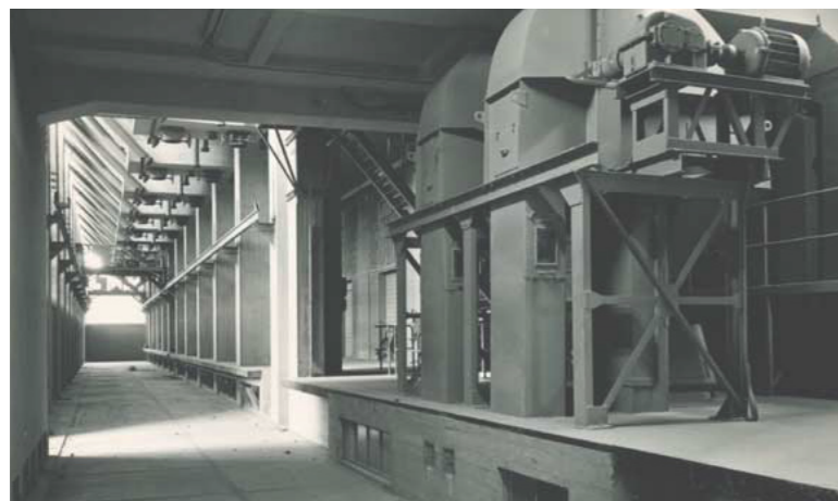
conveyor belts in the basement, Graansilo report, p.50-52
