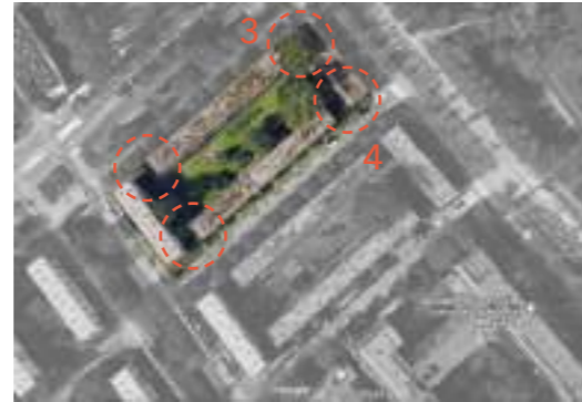
Entrance: Hengelolaan - Denekampstraat
