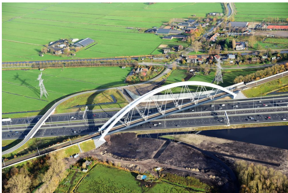
Figure 3: The Zandhazenbrug, Muiderberg (source:Rijkswaterstaat, 20108)
