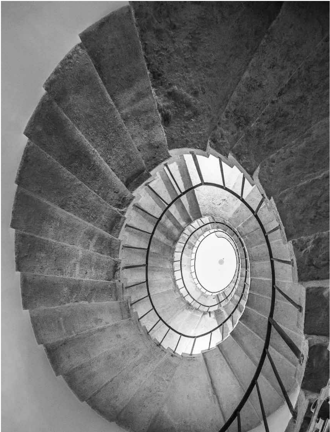
FIG. 7.19 Cantilevered stone stair, Convento Della Carita, Venice, Palladio 1561 (image Gardiner Hallock)
