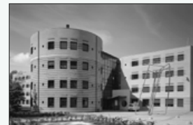
1990 Office centre 'Citadel' J. Dekkers
