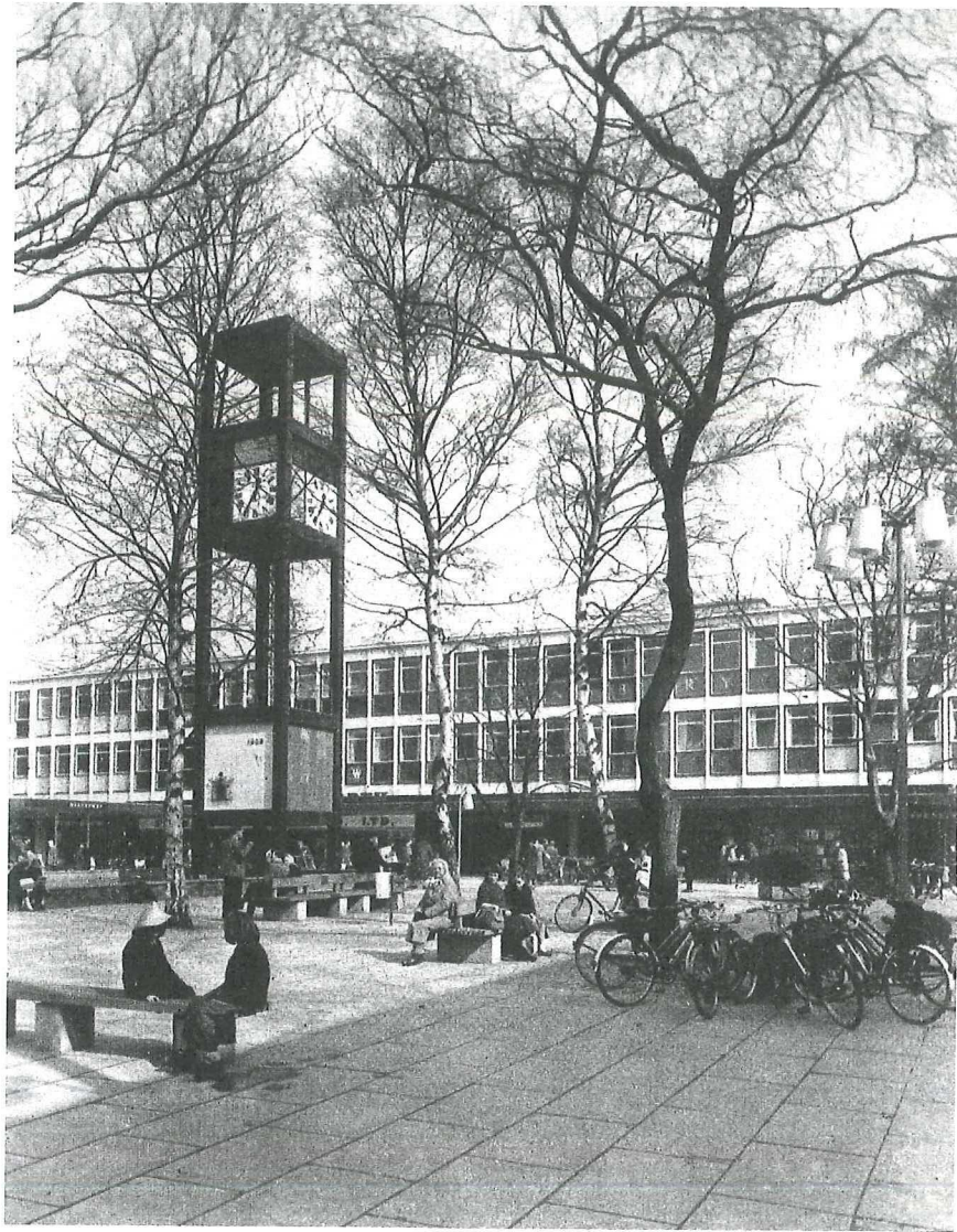
Figure 1.4 Stevenage Town Centre, 1966. Source: Collectie Het Nieuwe Instituut/Van Eesteren archive/EEST 10.8.
