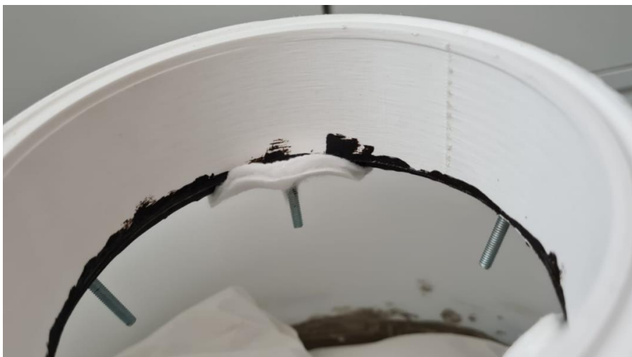
Figuur G4: Watjes geplaatst rondom de bouten om instromend water op te vangen.
