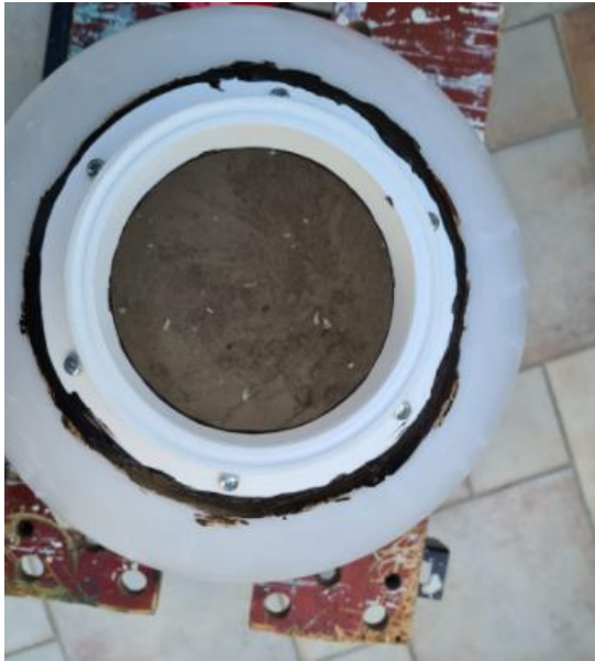
Figuur F12: Afgewerkte kitrand rond de hals.
