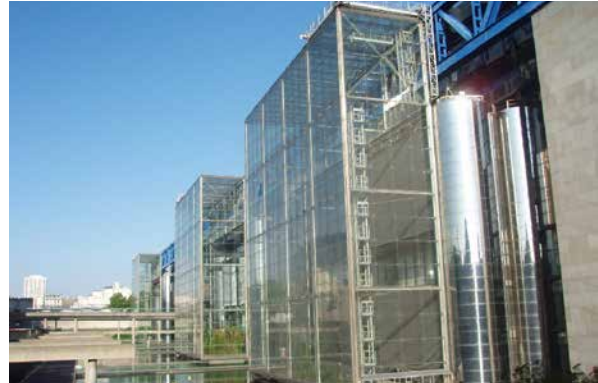
b View across the Canal de l'Ourcq to Cité des Sciences et de l'Industrie. (Photo: Author)
