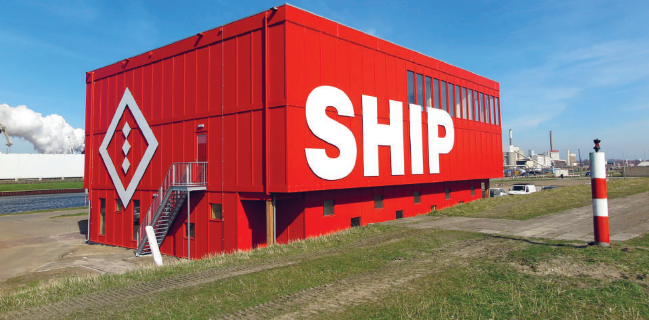
Het tijdelijke 'Sluis en Haven Informatiepunt' (SHIP) als een architectonische keet.
