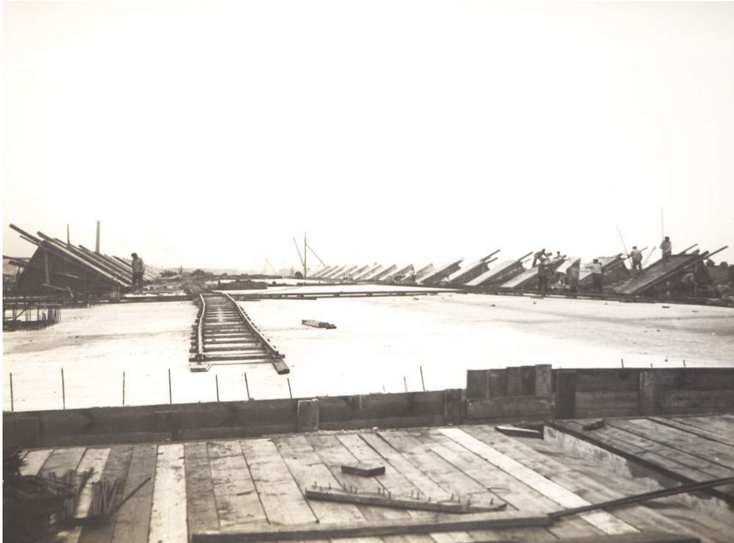
Roof construction Archief Holland-Amerika Lijn, Rotterdam
