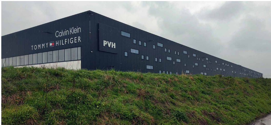
FIG. 2.40 PVH DC, Venlo. Photo: Merten Nefs.
