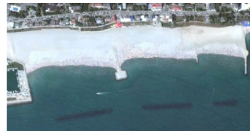
(d) Eforie beaches after construction (Google Earth Pro V7.1.8.3036, 2017b))
