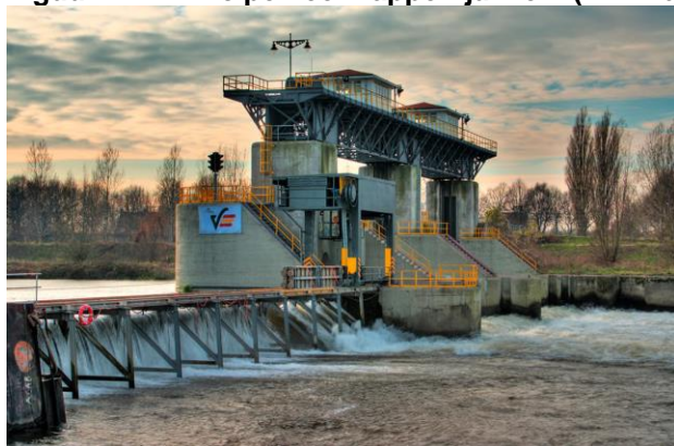
Figuur 13 - Stuw Roermond (IV-Infra,2010)
