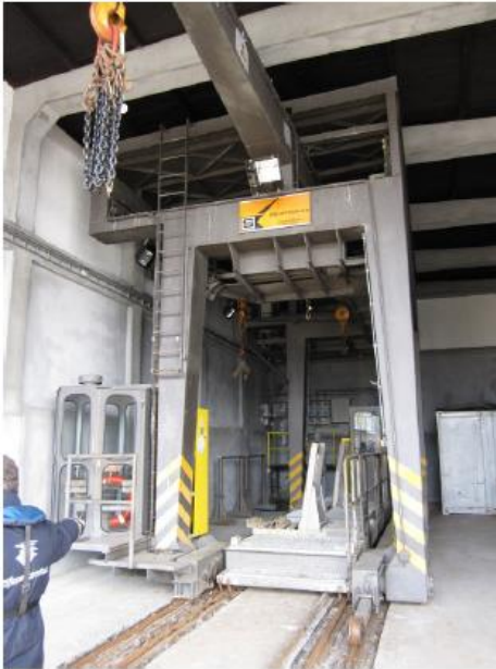
Figuur 53 - Schuivenloods Poiree (IV Infra)
