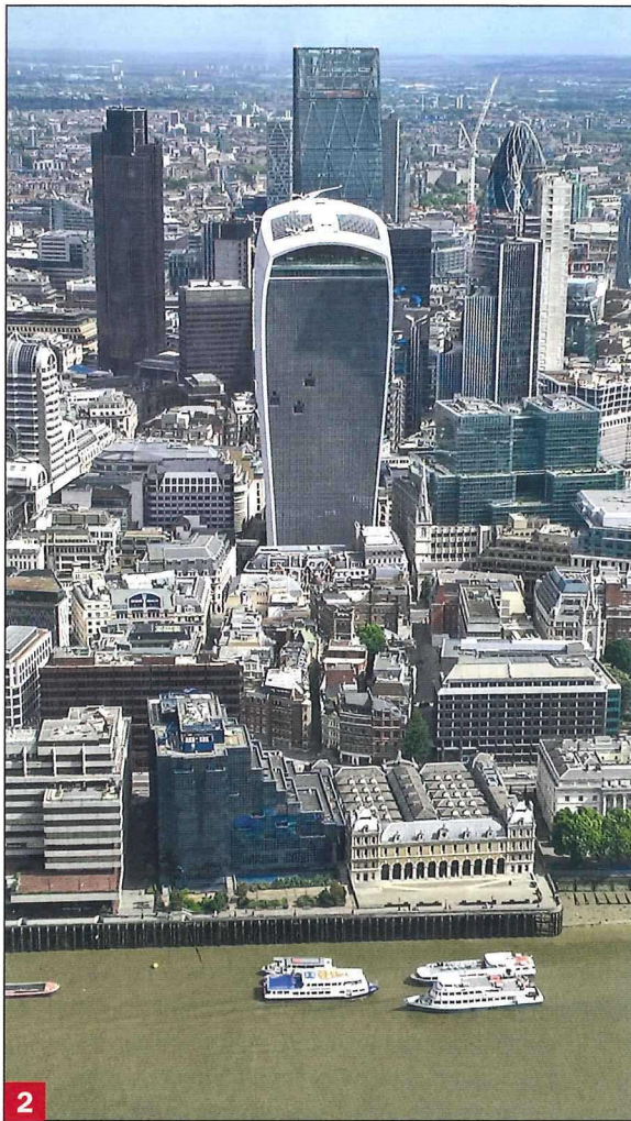
2 Het organisch gevormde gebouw in het midden van de foto heeft een glasgevel op het zuiden, uitkijkend over de rivier de Theems. Op de foto is inmiddels de (na voltooiing aangebrachte) externe zonwering zichtbaar, waarop we later terugkomen (foto: Roel Schipper, juni 2017)
