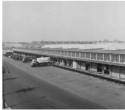
FIG. 2.31 Van Gend & Loos warehouse Amsterdam, 1956. Source: Spoorweg In Beeld.
