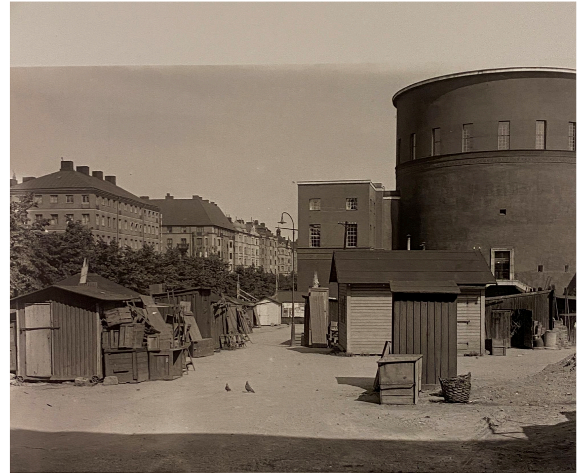
Stockholms stadsbibliotek 1928. Fortfarande syns spåren av en stor byggarbetsplats utmed Odengatan.
