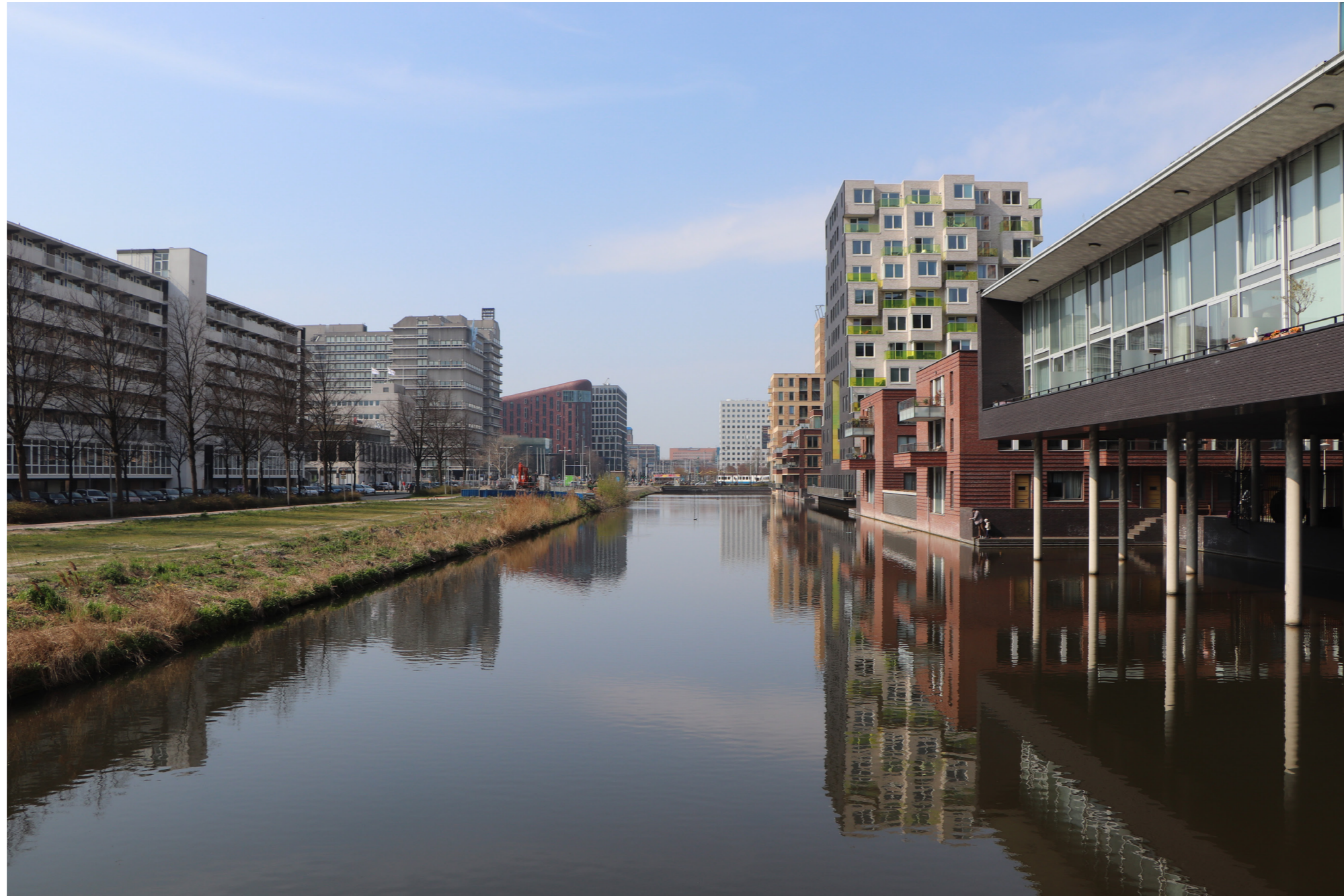
view from Lex van Deldenbrug, on the left Buitenveldert and on the right the Zuidas.
