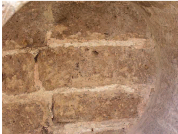
Fig. 10. Restant van de originele 11 e eeuwse pleister van de Pieterskerk in Utrecht, een kalkmortel met pannengruis.
