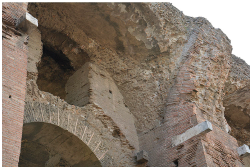
Fig. 5. Gebruik van opus caementitium in het paleis van Septimius Severus uit de 2 e -3 e eeuw na Chr (Foto S. Naldini).
