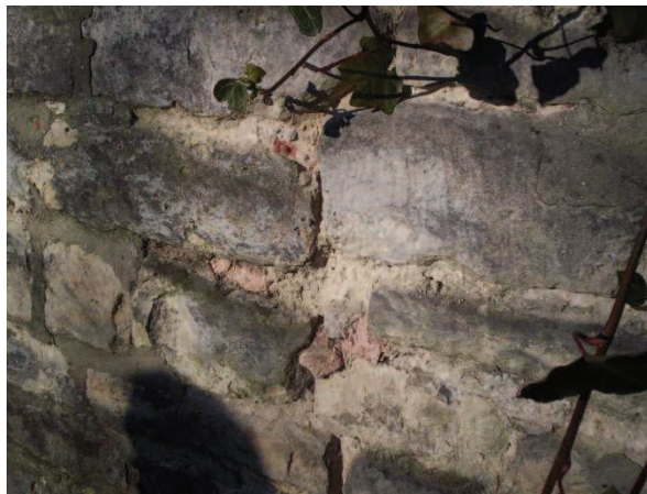
Fig. 11. Restant kalkmortel met pannengruis aan de 12 e eeuwse stadmuur van Leuven.
