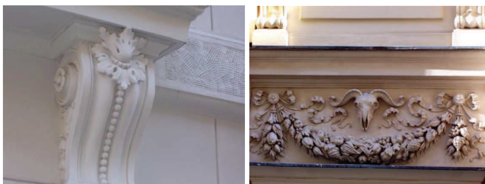
Fig. 9. Ornamenten uit Roman cement in Wenen (links Liebiggasse 5, rechts Rennegasse 20).
