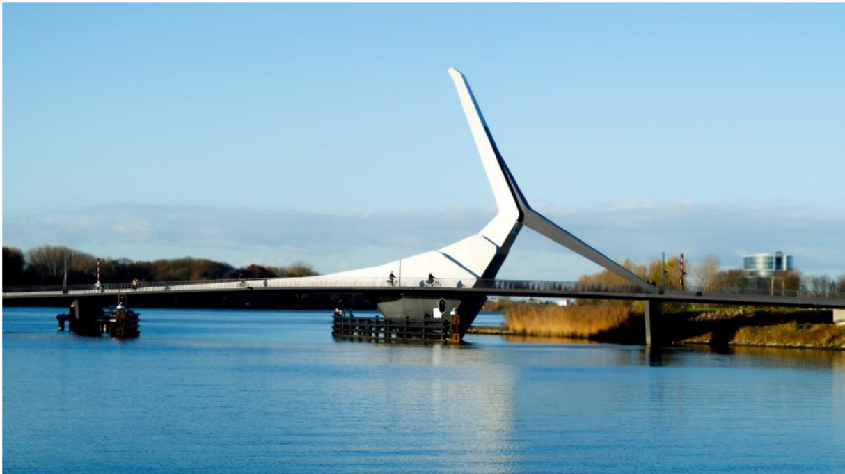
Figure A2: Prins Clausbrug, Dordrecht (René van Zuuk Architecten, 2021).
