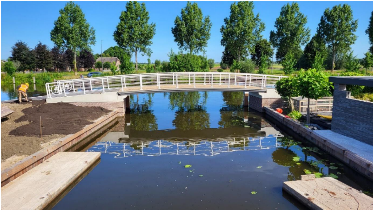
Figure A5: Bicycle bridge Enkele Wiericke, Nieuwerbrug (Hoogheemraadschap De Stichtse Rijnlanden, 2022).
