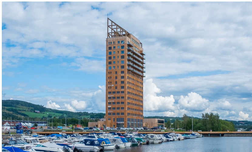
Figure A.8: Mjøstårnet, Brumunddal [4]
