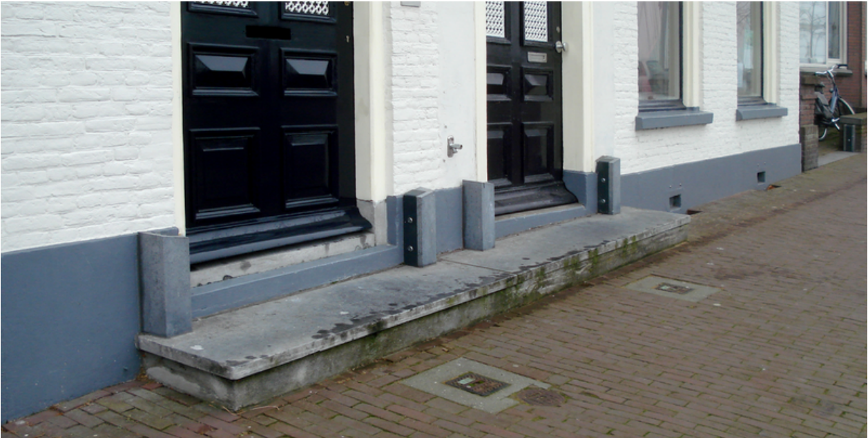
Kampen: Huizen langs de IJsselkade met voorzieningen om deuropeningen waterdicht te maken tot aan de waterkerende hoogte
