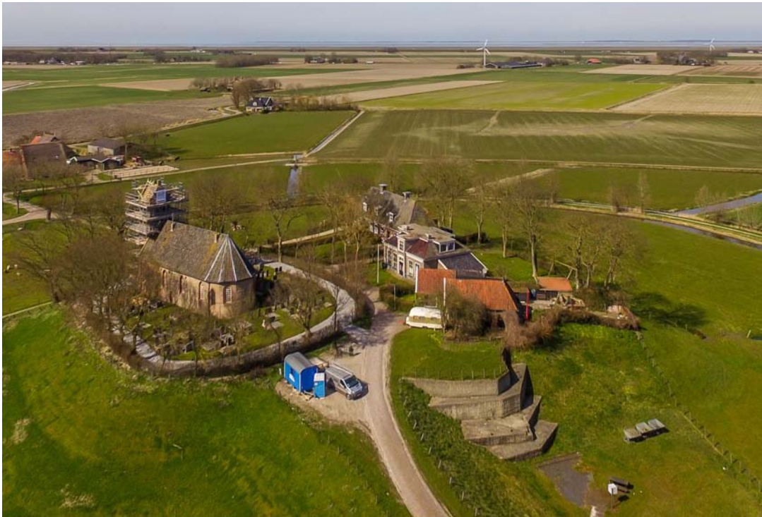
Fig. 2 Hogebeintum tijdens de werkzaamheden aan de toren. De opvallende betonnen structuren, het stuk rails en de drie kipkarren rechtsonder vormen samen een aandenken aan de afgravingen rond het begin van de 20ste eeuw. Foto J. Stöver, april 2016.
