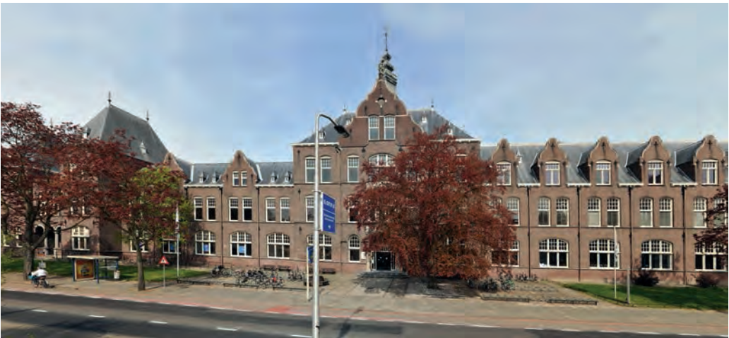
Voormalig gebouw voor Mijnbouwkunde, nu Science Centre TU Delft.
