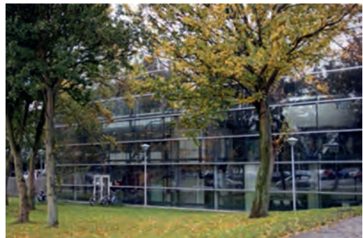
SIMONA laboratoriumgebouw, ontwerp van CEPEZED.
