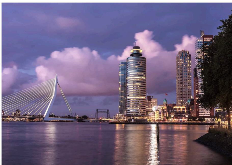
F. Erasmus bridge, Rotterdam. (n.d.).
