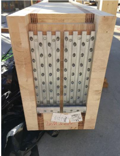
(D) Connection detail (beam) [33]
