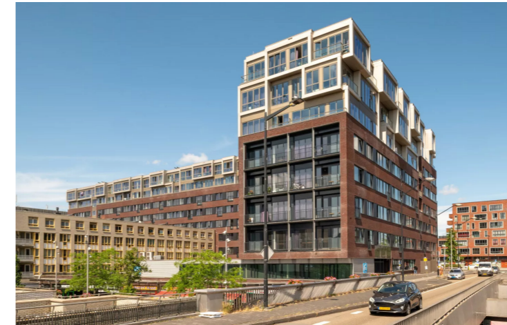
GoedverzorgdOnline. (2022, May 30). Transformatie Flierbosdreef | Projecten | De Loods Architecten en Adviseurs. De Loods Architecten En Adviseurs. https://deloods.nl/projecten/transformatie-flierbosdreef/
