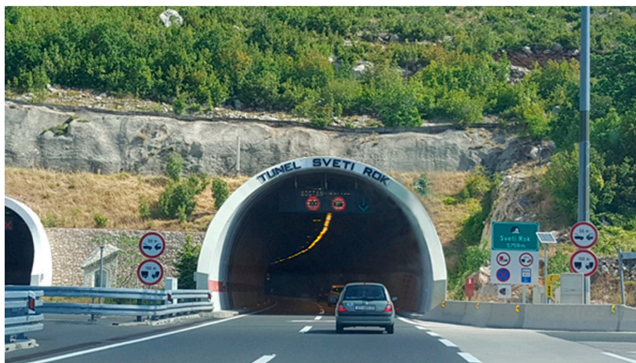
Figure 9. Sveti Rok road tunnel.
