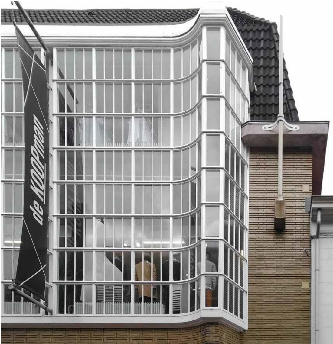
6. FRAGMENT PHOTOGRAPH OF THE UTRECHTSESTRAAT FACADE
