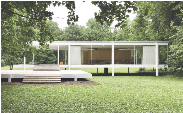
The Farnsworth House / Mies van der Rohe
