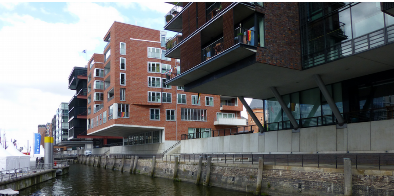
Hamburg: Appartementenblokken langs de Elbe, die wel water keren, maar niet het achterliggende land beschermen
