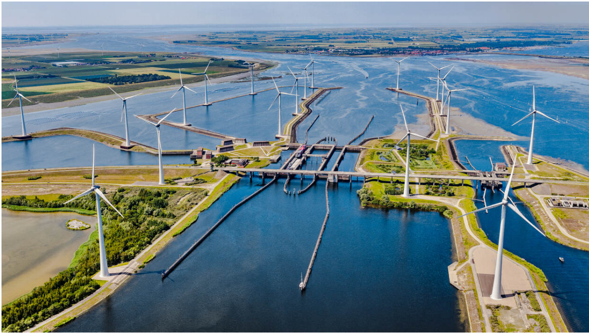
Figure 5.1: Overview of Krammersluizen complex (source:Rijkswaterstaat)
