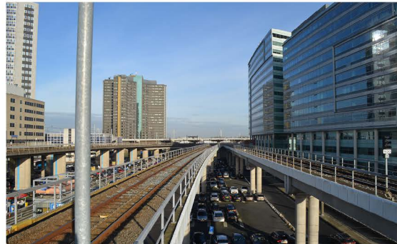
Metro platform view Sloterdijk. (Owen source)
