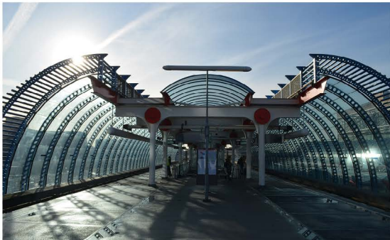
Metro platform view Sloterdijk. (Owen source)
