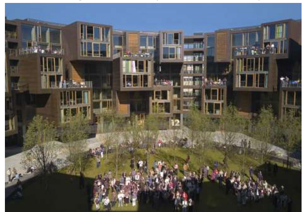
Courtyard Tietgen Dormitory (Lindhe, J. M., 2014a)
