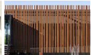
Corten steel collonade of Centre d'Examen du Permis
