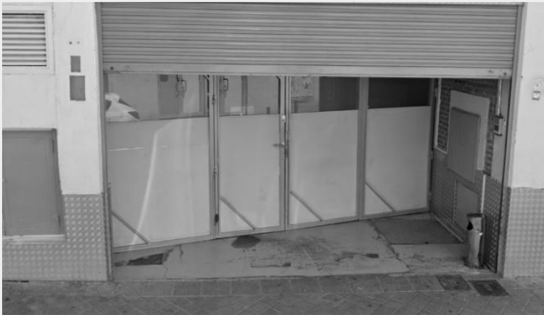
📍 Fachada Centro Geranios II
