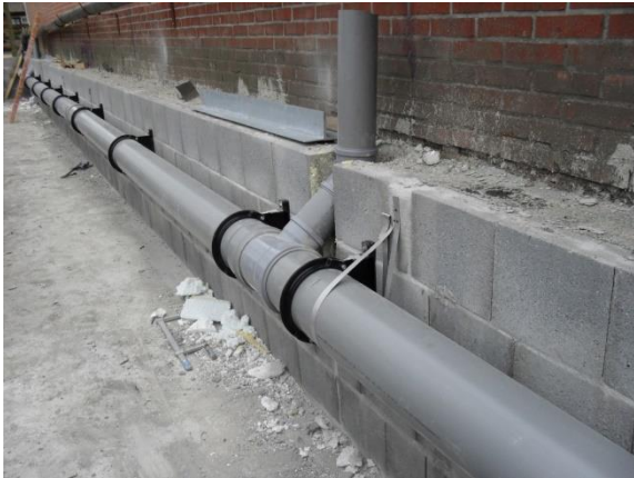
Figuur 5.2 Verzamelleiding regenwater (Jovas, 2016)
