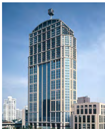
Fig. 2-34 Emporium Suites Tower
