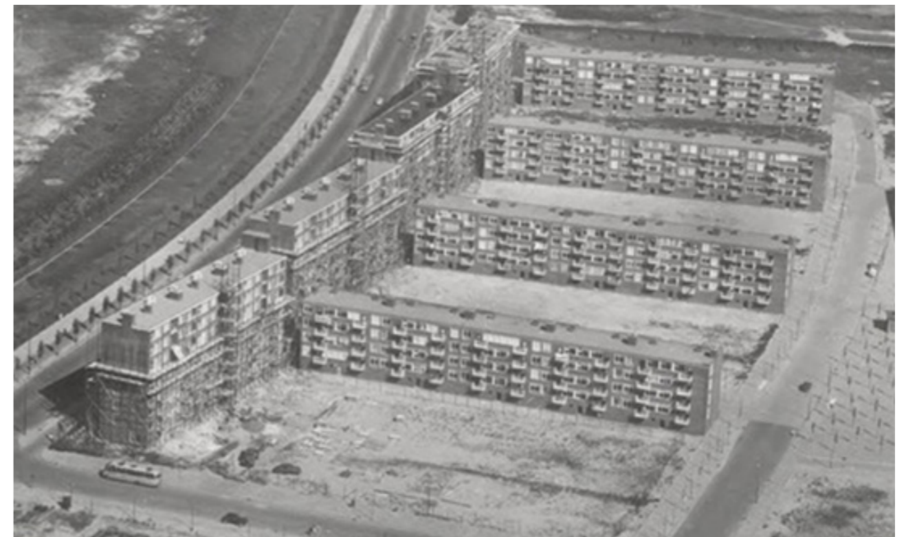
Image 4. Knijtijzerpanden, Jan Evertsenstraat 201-471, under construction.
