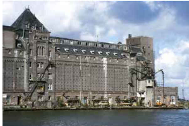
Silodam Amsterdam 1995 (now reused) (vanstigt.nl)
