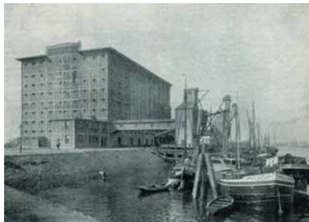
Maassilo 1st part of Stok ca. 1910 (rapport CV graansilo maashaven)
