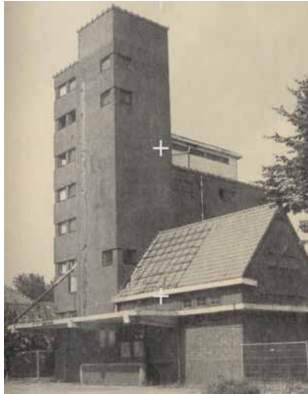
Silo at the countryside with brick cladding (Loeff, K. (2004). Kathedralen van het platteland, Silogebouwen van graan- en veevoederbedrijven in Nederland. Zwolle, The Netherlands: Tjil offset. )
