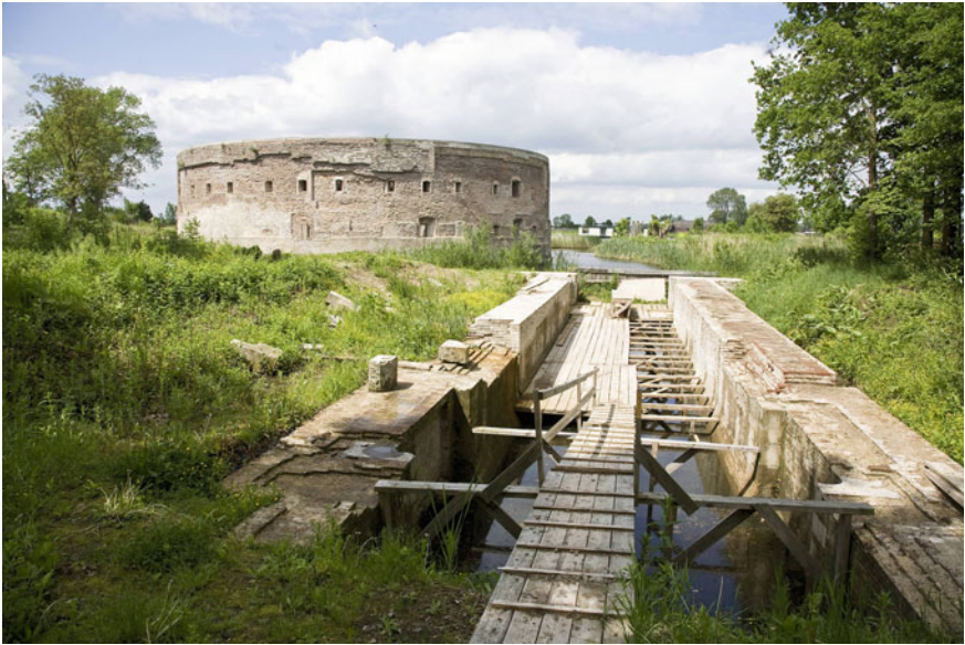
Torenfort Uitermeer, a part of the New Dutch Waterline with a bridge construction, 2008, Bert van As for the Rijksdienst voor het Cultureel Erfgoed, Wikimedia, released under a Creative Commons Attribution-Share Alike 4.0 International license
