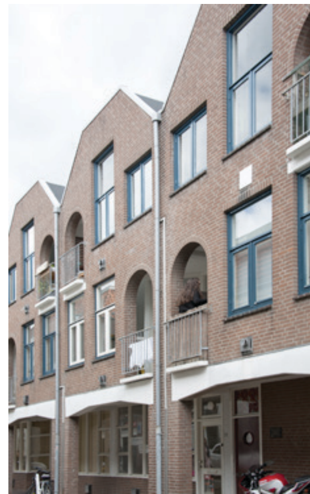
Exterieur Nieuwstraat Exterior Nieuwstraat
