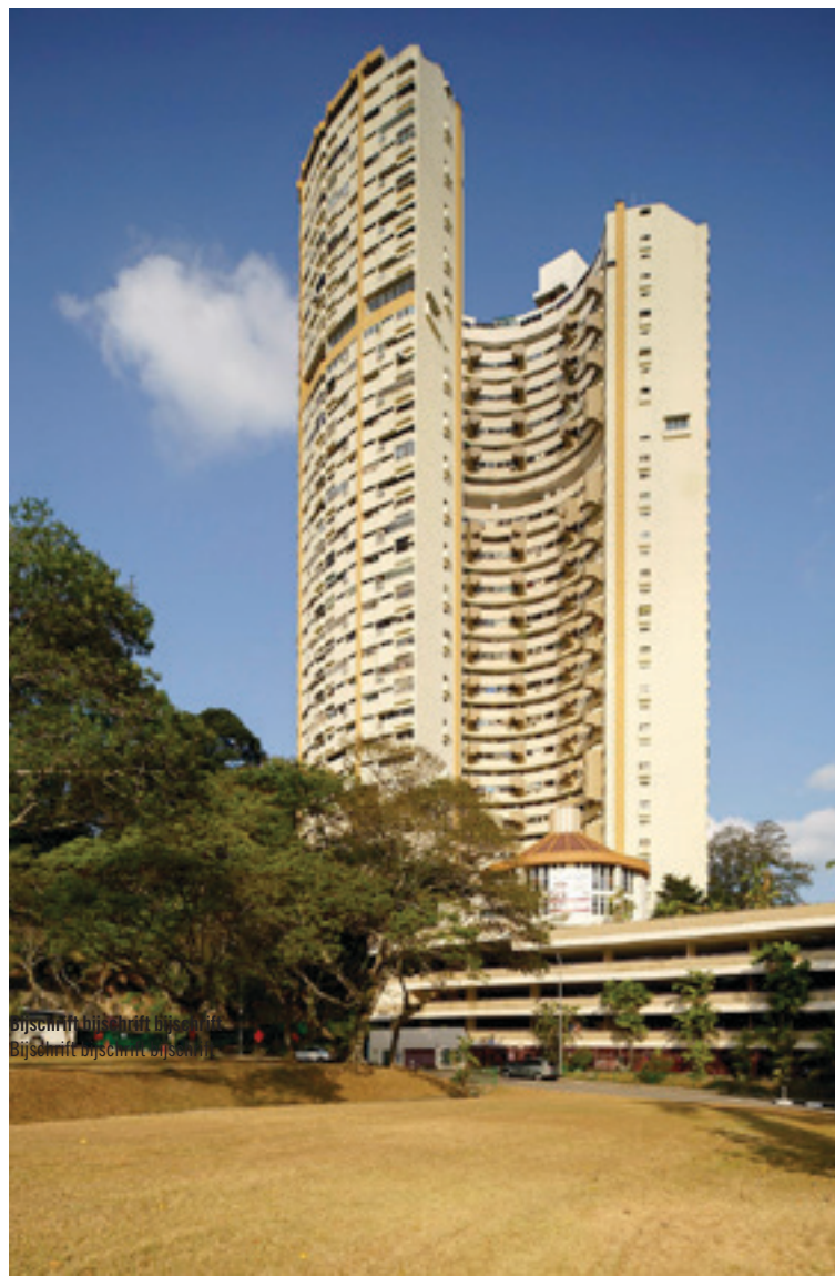
Kort voor de sloop Shortly before demolition
