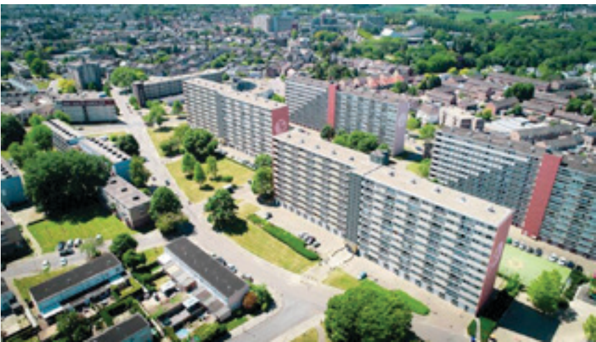
De bestaande flats op het Rolduckerveld in Kerkrade The existing flats on the Rolduckerveld in Kerkrade
