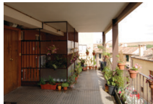
Historische foto van de lage galerij van blok V van El Taray met halfhoge keuken- en badkamerramen en schermen van de wasruimten Historical photo of the lower gallery of the block V of El Taray with half-height windows of kitchens and bathrooms and the laundry spaces screens
