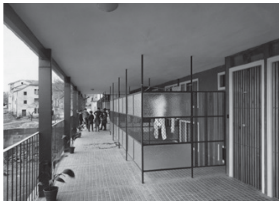
Historische foto van de lage galerij van blok V van El Taray met halfhoge keuken- en badkamerramen en schermen van de wasruimten Historical photo of the lower gallery of the block V of El Taray with half-height windows of kitchens and bathrooms and the laundry spaces screens
