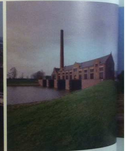
Lemmer, Estación de bombeo a vapor D.F. Woudgenemaal, foto: RCE, T. van der Wel, 1997 / Lemmer, steam-powered pumping station D.F. Woudgenemaal built 1920, photo: RCE, T. van der Wel, 1997.
