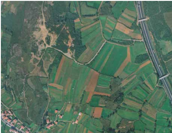
FIG. 6.5.1.12 Site prior to excavation (Eisenman 2005 p.10)
