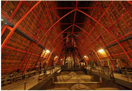
FIG. 3.1.5.6 Steel structure Kölner Dom (Photo: Kaspar H.)
