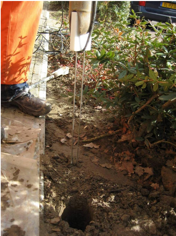
Figuur 0.3 Plaatsing van een vochtmeter.
