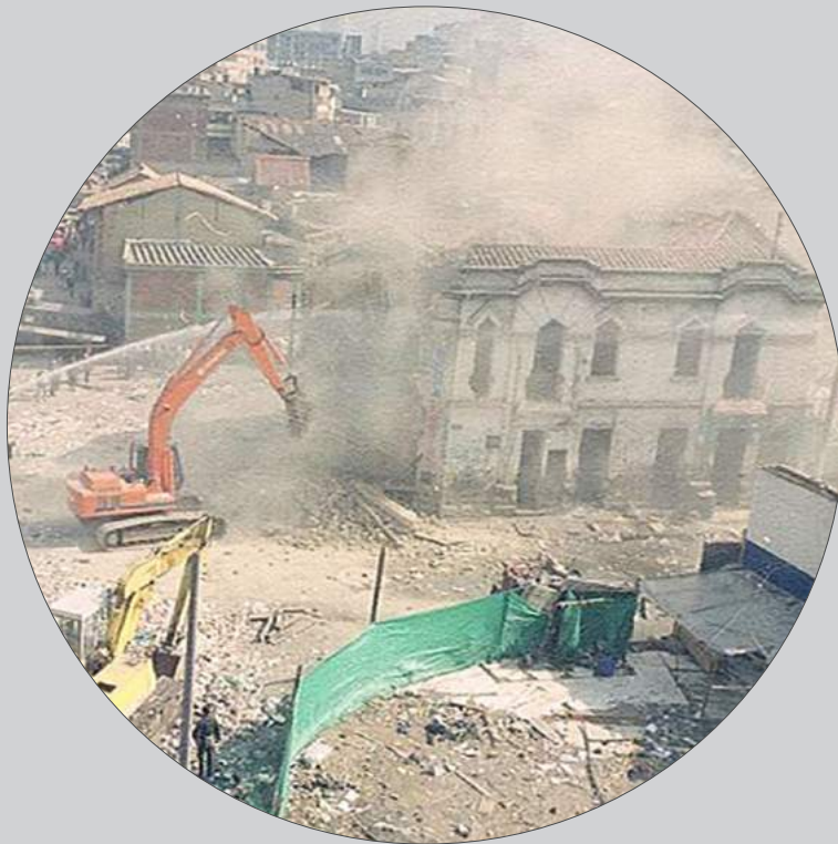
demolition El Cartucho (1998)
