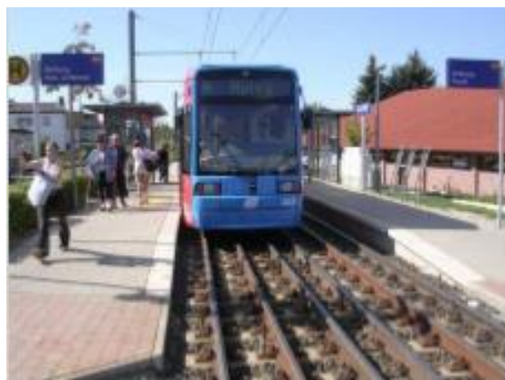
Figure 4-5: 6-rail track at Hessisch-Lichtenau. Axel Kühn.
