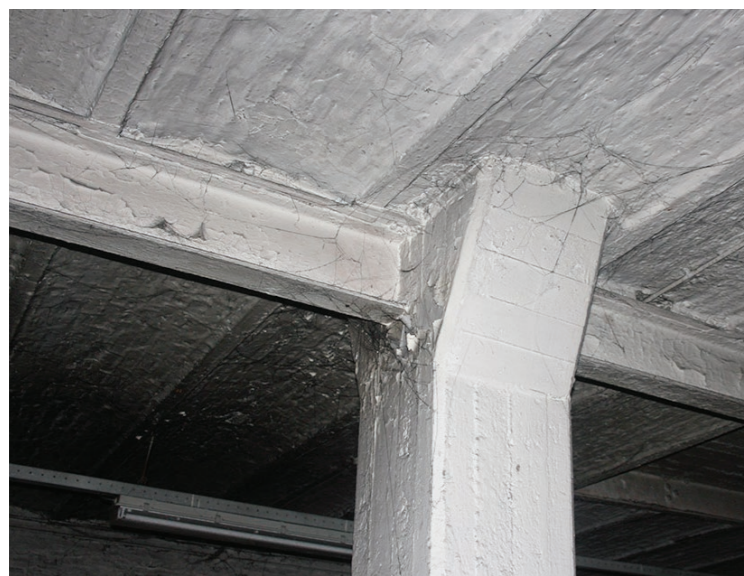
Decombinatie van betonkolommen met stalen liggers en baksteen troggewelven geven een aparte combinatie. Hier is de 'versmelting' duidelijk leesbaar.
