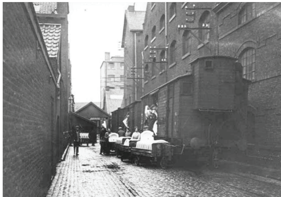
De werknemers van de Shpinx hadden vanaf de straat een goede kijk op het brikkengebouw
