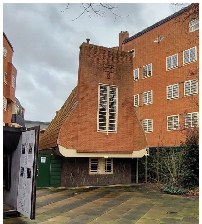
Figuur 48 | Binnenplaats met vergaderruimte Eigen Haard
