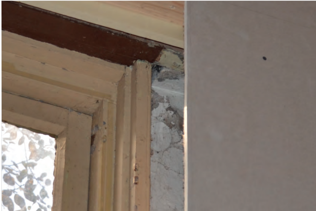
Afbeelding 25: Binnenisolatie achter gipskarton, Landgoed Sevenaar, november 2019 (foto Martin Tenpierik)
