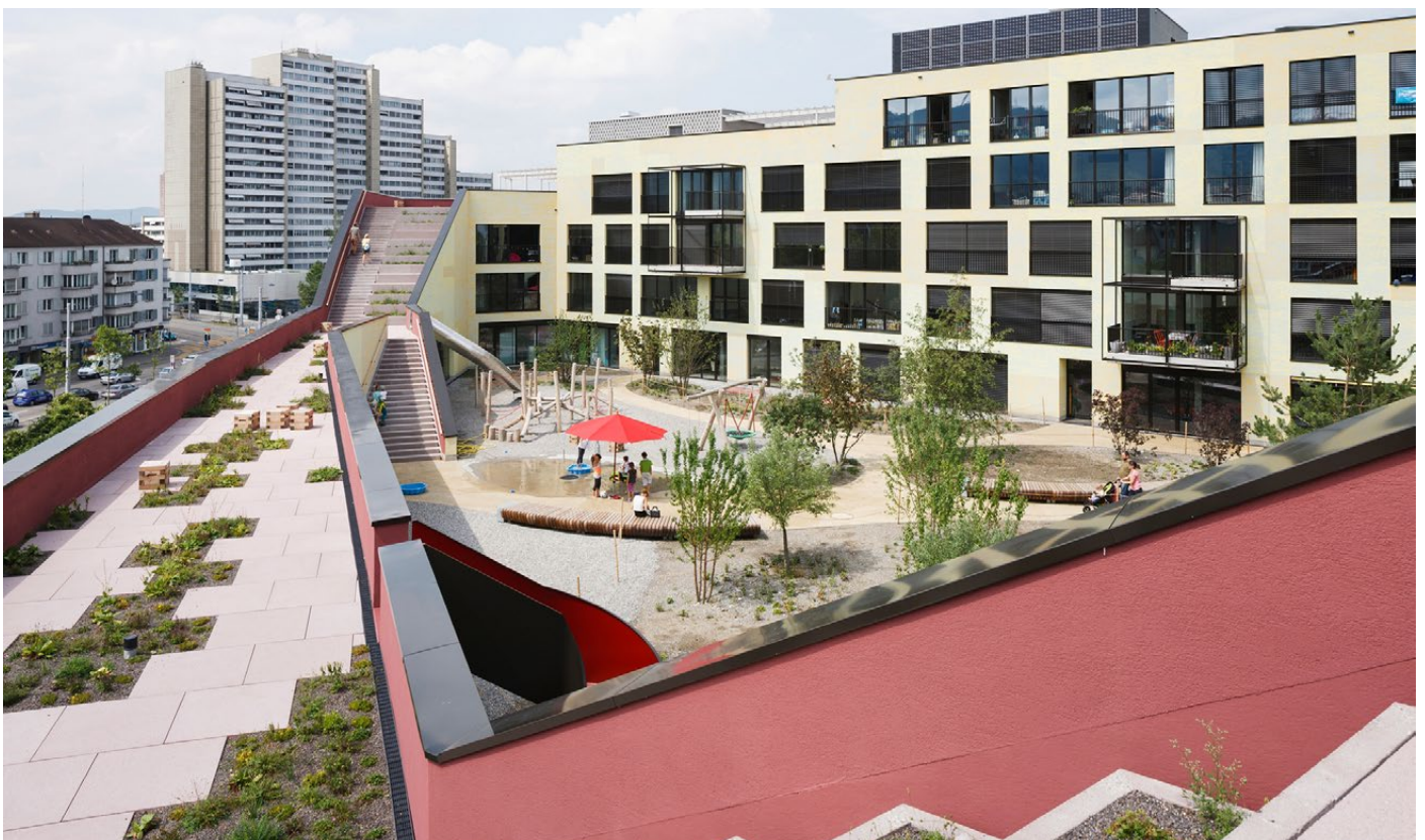
Kalkbreite housing complex, Müller Sigrist Architekten https://www.archdaily.com/903384/kalkbreite-muller-sigrist-architekten
